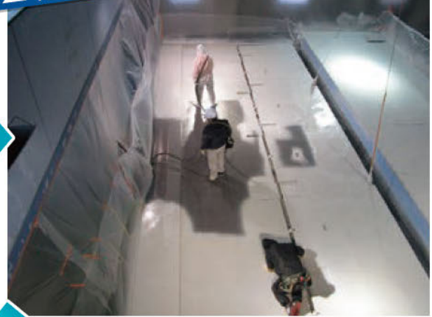
2 防水層 (P-3300) 吹付け中
