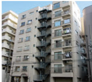
施工部位 屋上・ルーフバルコニー 工法名 SDIAK30Tフッ素 (UNマシンステム) 施工員会社 株式会社 株式会社 現場施工責任者 奥田賢則
