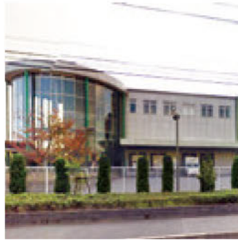
施工部位 屋上 工法名 QV-KK50T 施工員会社 株式会社 株式会社 現場施工責任者 細貝裕介
