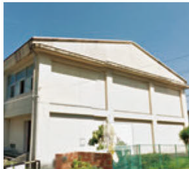
施工部位 折半屋根 工法名 リムスプレー SRIFF20TWサーモ 施工員会社 株式会社 株式会社 現場施工責任者 今岡泰隆
