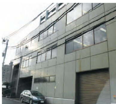
施工部位 屋上 工法名 AMECO30TJ 施工員会社 株式会社ヒキフルフ 現場施工責任者 高山奨平氏
